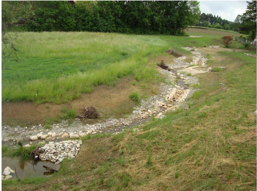
Abbildung 5: Beispiel eines renaturierten Wiesenbaches mit Blocksteinrampe, Kiessohle, Störsteinen und Holzstrukturen. Foto: RSW AG
