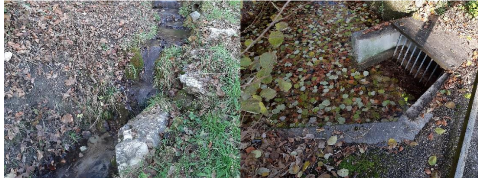
Abbildung 3: Links: wenig beeinträchtigtter Abschnitt mit Rampe aus Blocksteinen. Rechts: Schlamm-sammler mit Rechen. Gemäss Gefahrenkarte Ort der Ausuferungen bei Abflüssen >HQ30. Foto: RSW AG
