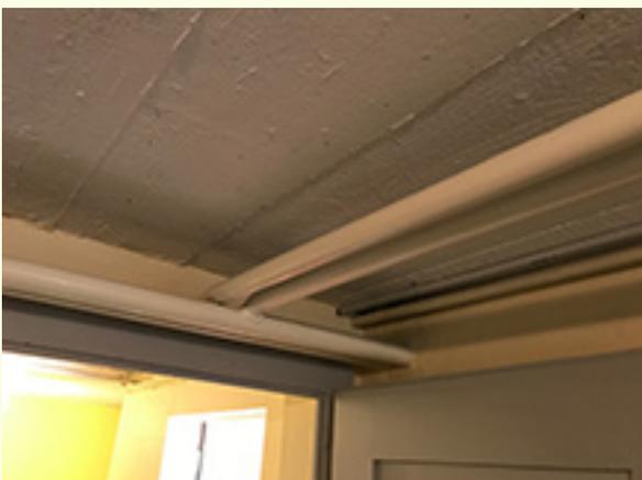
Während der Heizperiode geht in diesem Haus unnötig Wärme im Keller verloren, weil die Heizleitungen nicht gedämmt sind. Die Dämmung lohnt sich sehr, denn die Kosten für das Dämmmaterial und für den Arbeitsaufwand sind rasch amortisiert.
