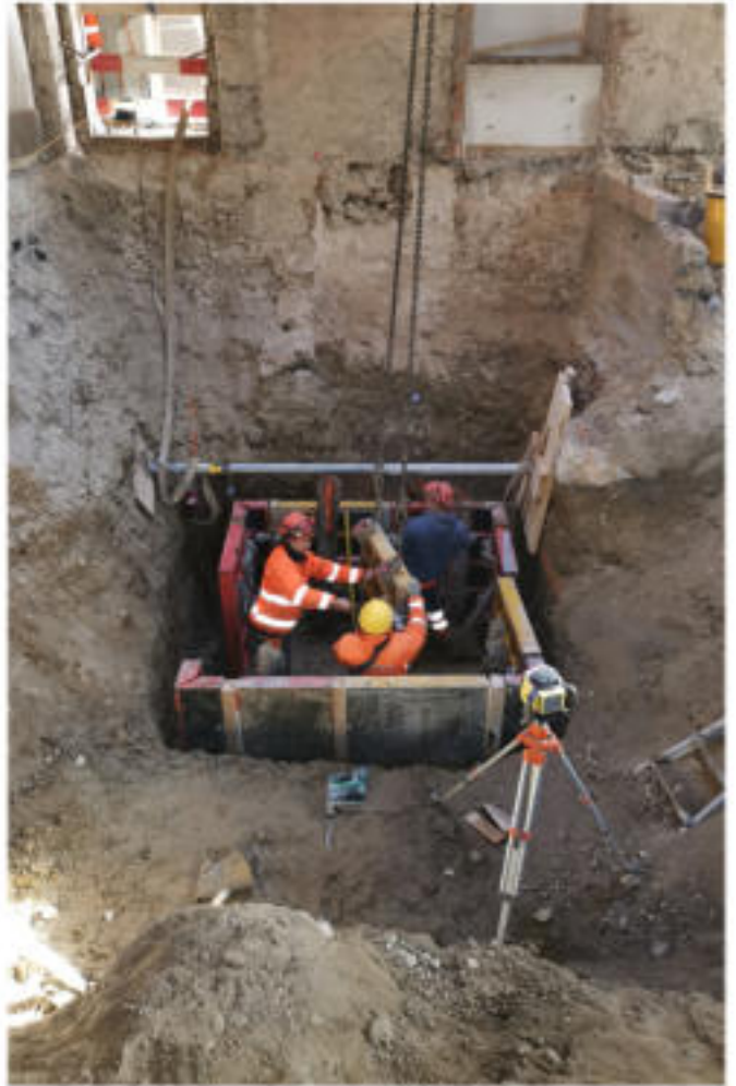
Eine 4 Meter tiefe Grube musste für den Liftschacht und Keller ausgehoben werden.
