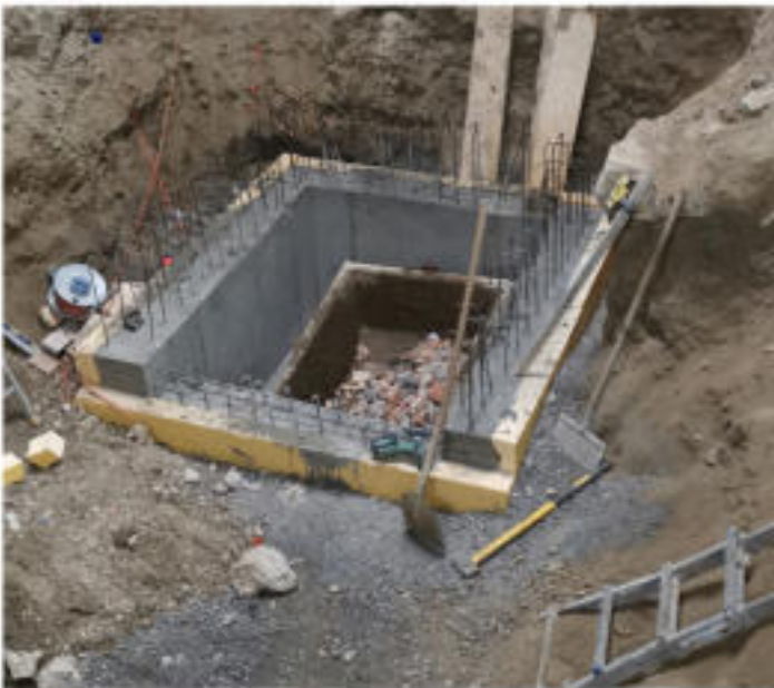
Eine 4 Meter tiefe Grube musste für den Liftschacht und Keller ausgehoben werden.
