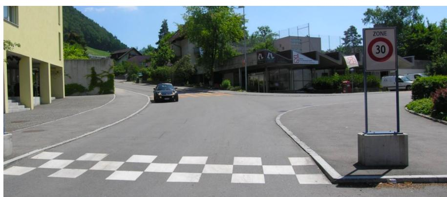
Abbildung 11: Schachbrettmuster bei Tempo-30-Zoneneingang (Bsp. bfu-Grundlage)
