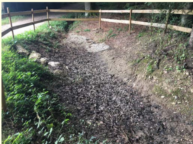
Vergrössertes Auffangbecken oberhalb Bänkli
