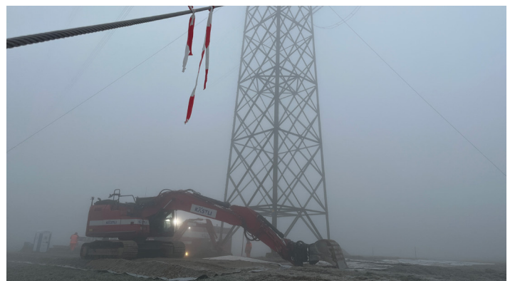
Trotz Schnee, Dunkelheit und Nebel: Die Bauarbeiten zwischen Bassecourt und Mühleberg sind auf Kurs.
